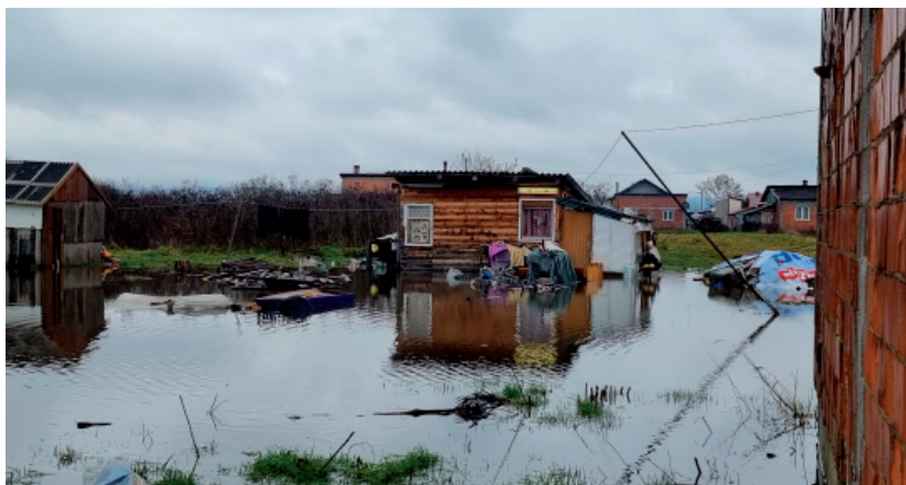
Život u romskom naselju: trošna kuća u naselju J.Rimac u Sl. Brodu
